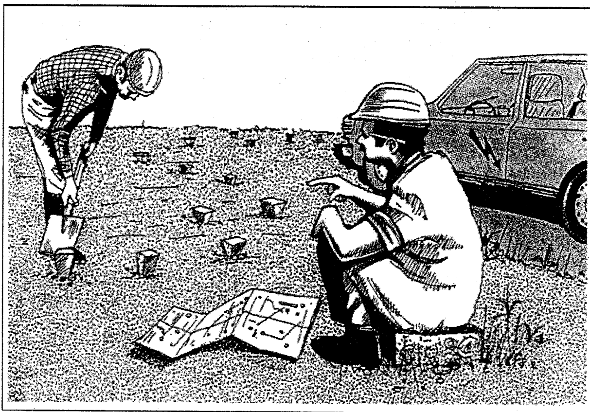
Figura 12. Localizarea cablurilor electrice îngropate folosind un plan și marcarea poziției acestora
