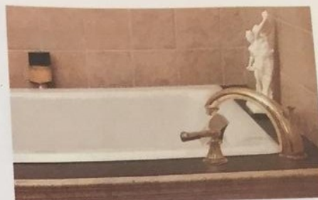
Sigilați linia de joncțiune între plăcile de faianță și marginea căzii cu un strat de silicon flexibil.
