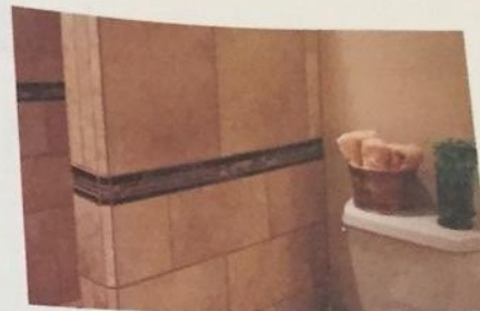
Puteți conferi un aspect diferit spațiului din baie în care se găsește dușul, inserând un rând de listuri, și modificând dimensiunea plăcilor ceramice fixate deasupra acestui rând.
