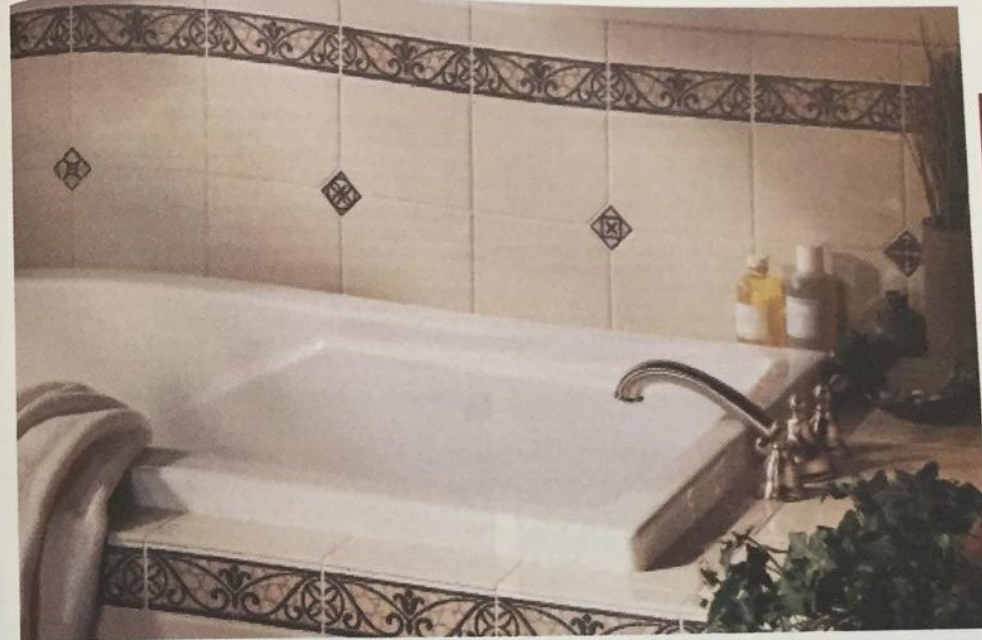
Plăcile ceramice montate în spațiile expuse umezelii, în jurul căzii și a lavoarului, ar trebui susținute de către panouri fabricate din materiale pe bază de ciment (cunoscute sub denumirea de Placoem).
